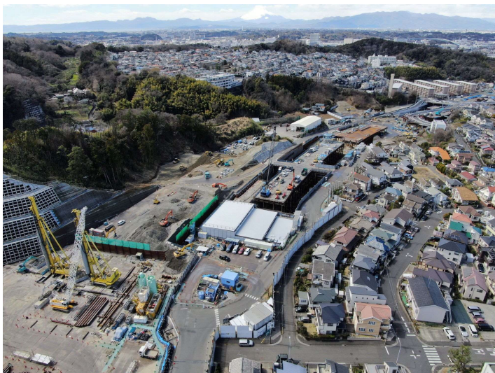
公田IC(仮称)側 状況
