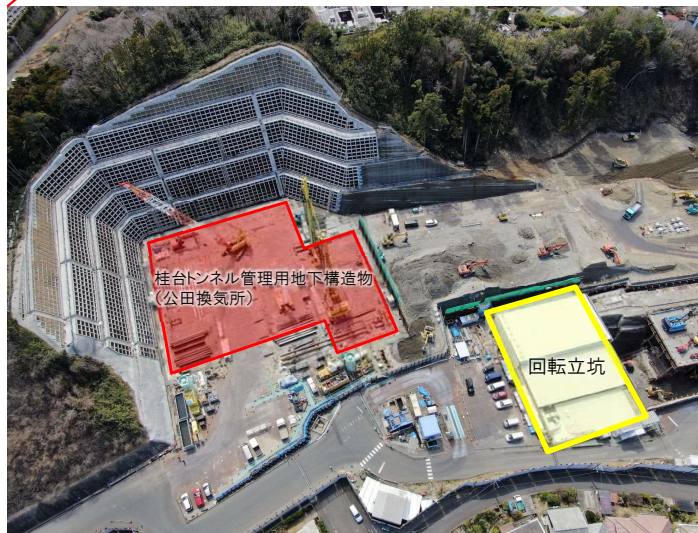
公田換気所周辺 状況
