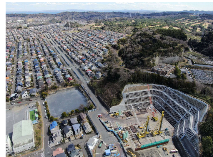
桂台TN工事側 状況
