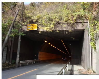
坑口部(金沢区側)
