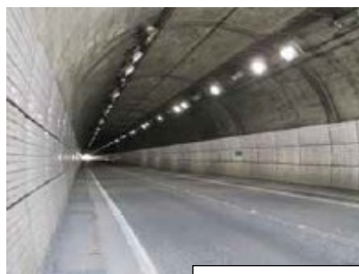
トンネル内部
